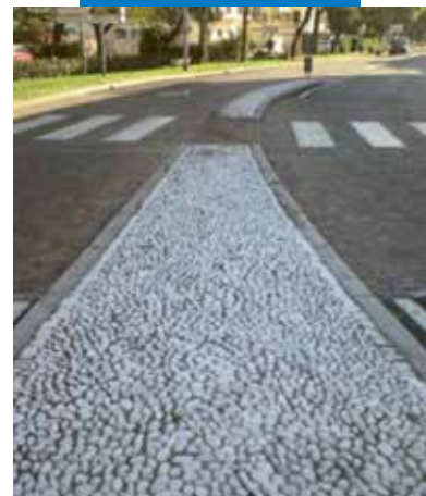
Járműforgalomnak kitétt út kavicsburkolatos járdaszíggel
